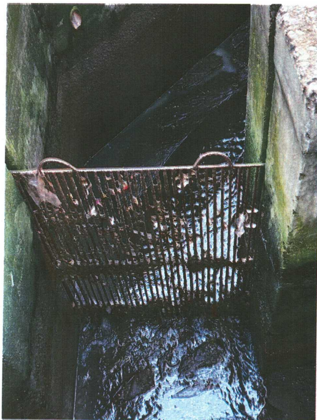
Foto 06 – Areia e partículas no gradeamento - remoção janeiro 2022
