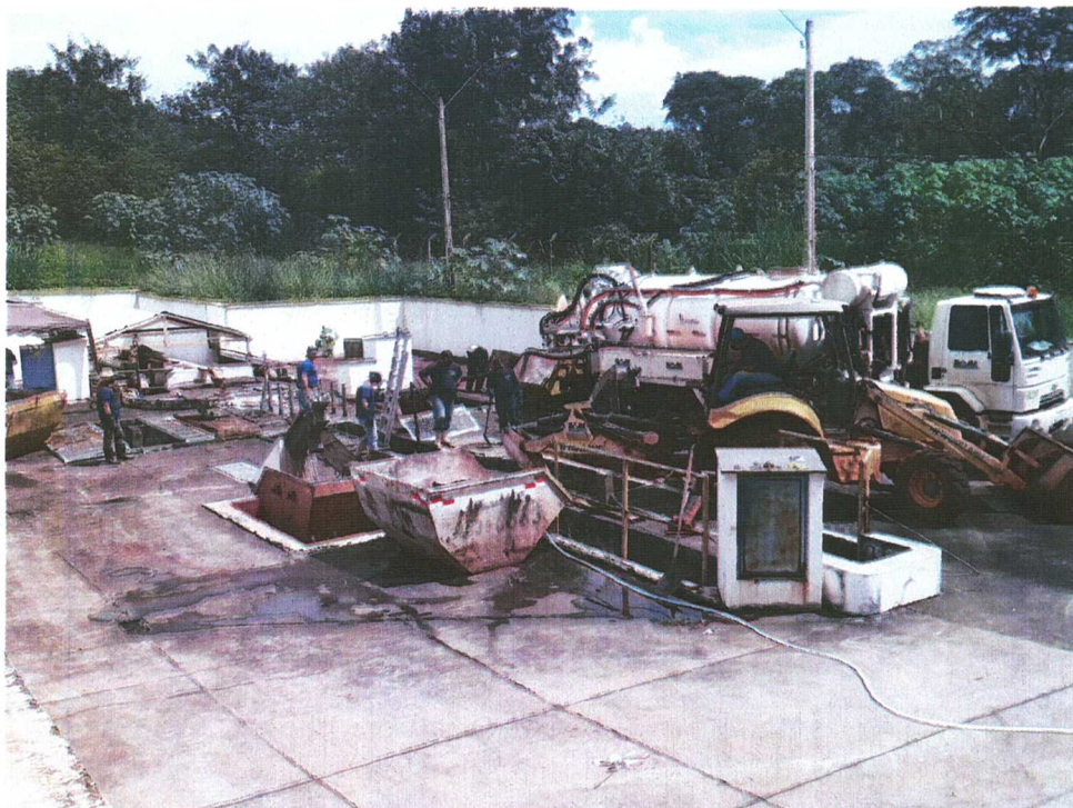
Fotos 01 e 02 – EEE 01 Limpeza da caixa de areia e calha parshall.
