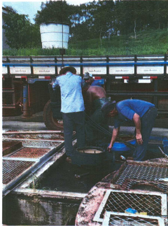
Foto 09- Retirada da bomba submersa para manutenção em fevereiro de 2022.
