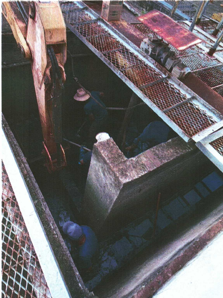
Foto 05 – Imagem da caixa de areia em manutenção
