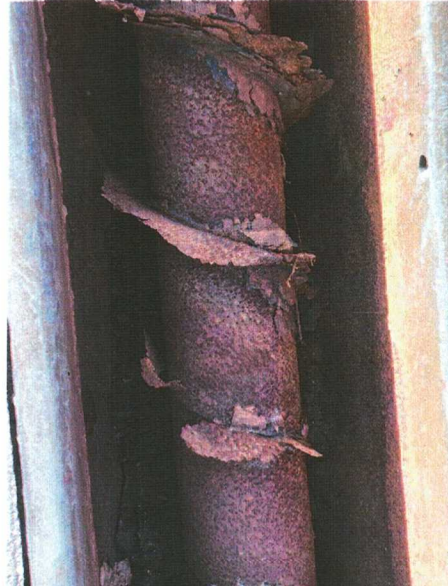
Fotos 03 e 04- Imagens das transportadoras helicoidais de areias atualmente.
