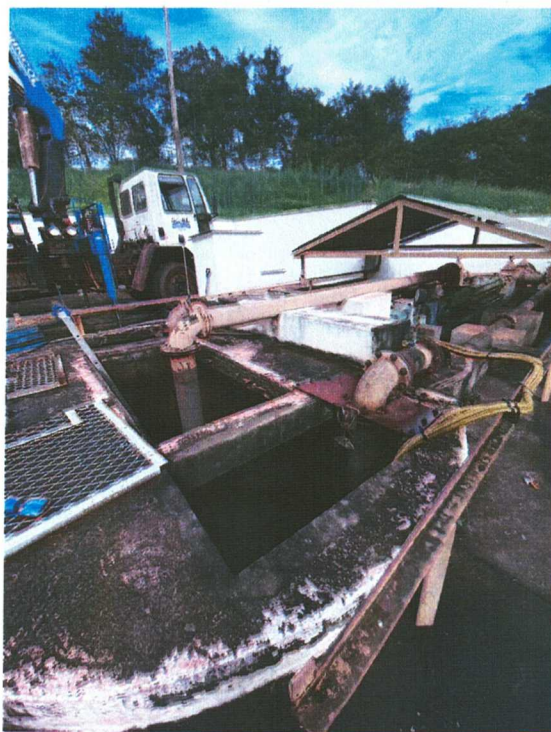
Foto 08- Retirada da bomba submersa para manutenção em fevereiro de 2022.
